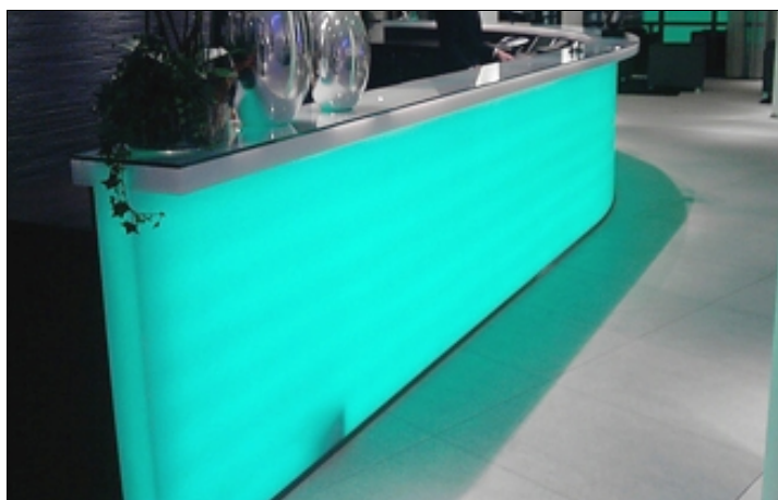
Door te werken met de specifieke samenstelling van de plaat kan men deze doorschijnend maken waardoor men met ingewerkte verlichting kan werken
